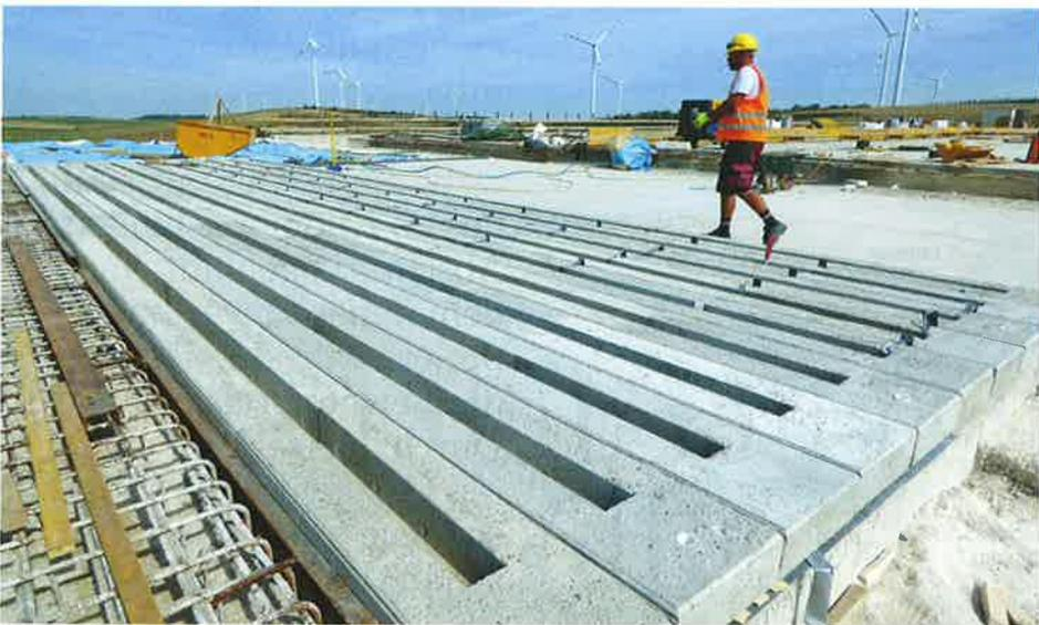
Für eine 112 m lange integrale Autobahnbrücke im Zuge des Weiterbaus der A5 kommt eine neuartige Fahrbahnübergangskonstruktion zum Einsatz. Sie besteht im Wesentlichen aus aneinandergereihten Betonelementen, die durch korrosionsgeschützte Zugglieder miteinander verbunden sind und auf einer Gleitfläche aufliegen.
