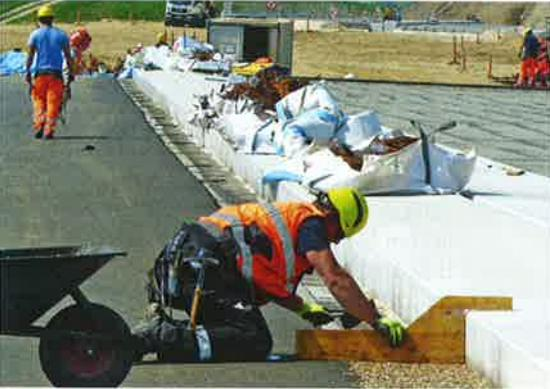
Detailarbeiten im Brückenbereich. Unter anderem wird ein mit Kunstharz gebundener Kies für die Entwässerung eingebaut.
